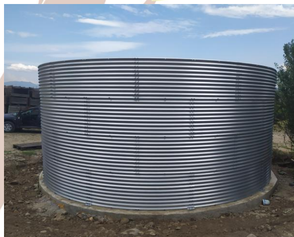
Foto 5. Bazin subteran și bazin suprateran de colectare și stocare a apei
